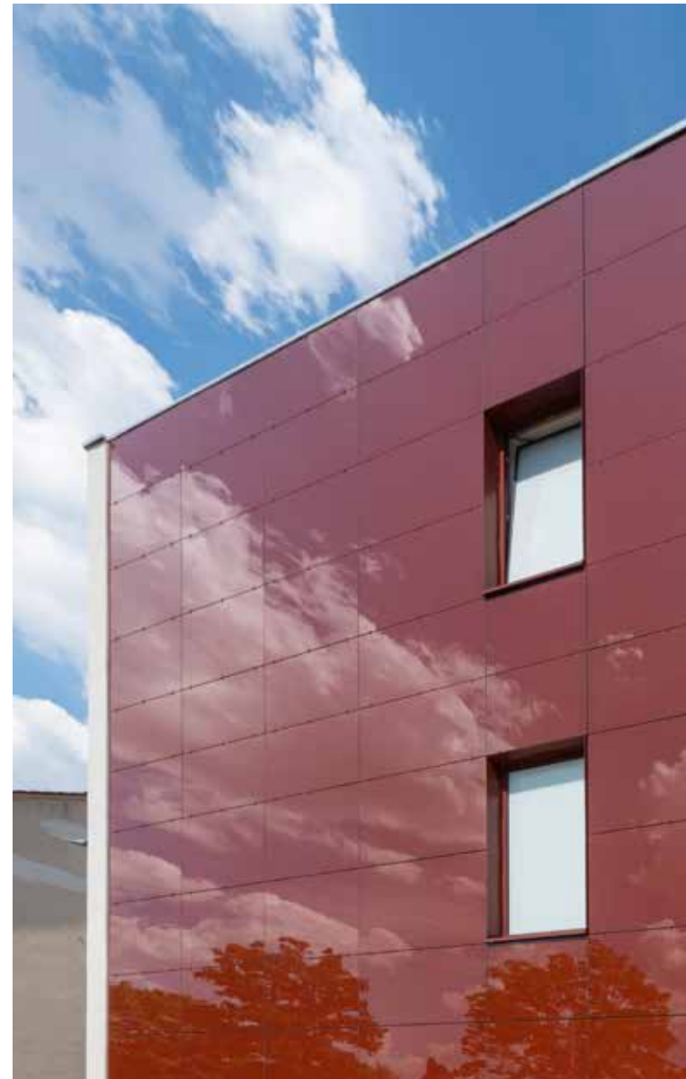
Photovoltaik-Fassade: Smarte Gebäudehülle mit Mehrfachnutzen
